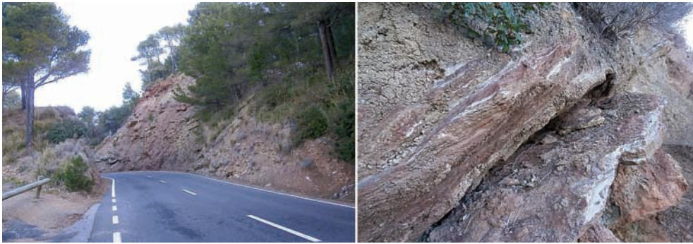
Fig. 43. Coll de sa Gramola i desprendiments en material Keuper. Guixos i margues irisades de l'indret.
